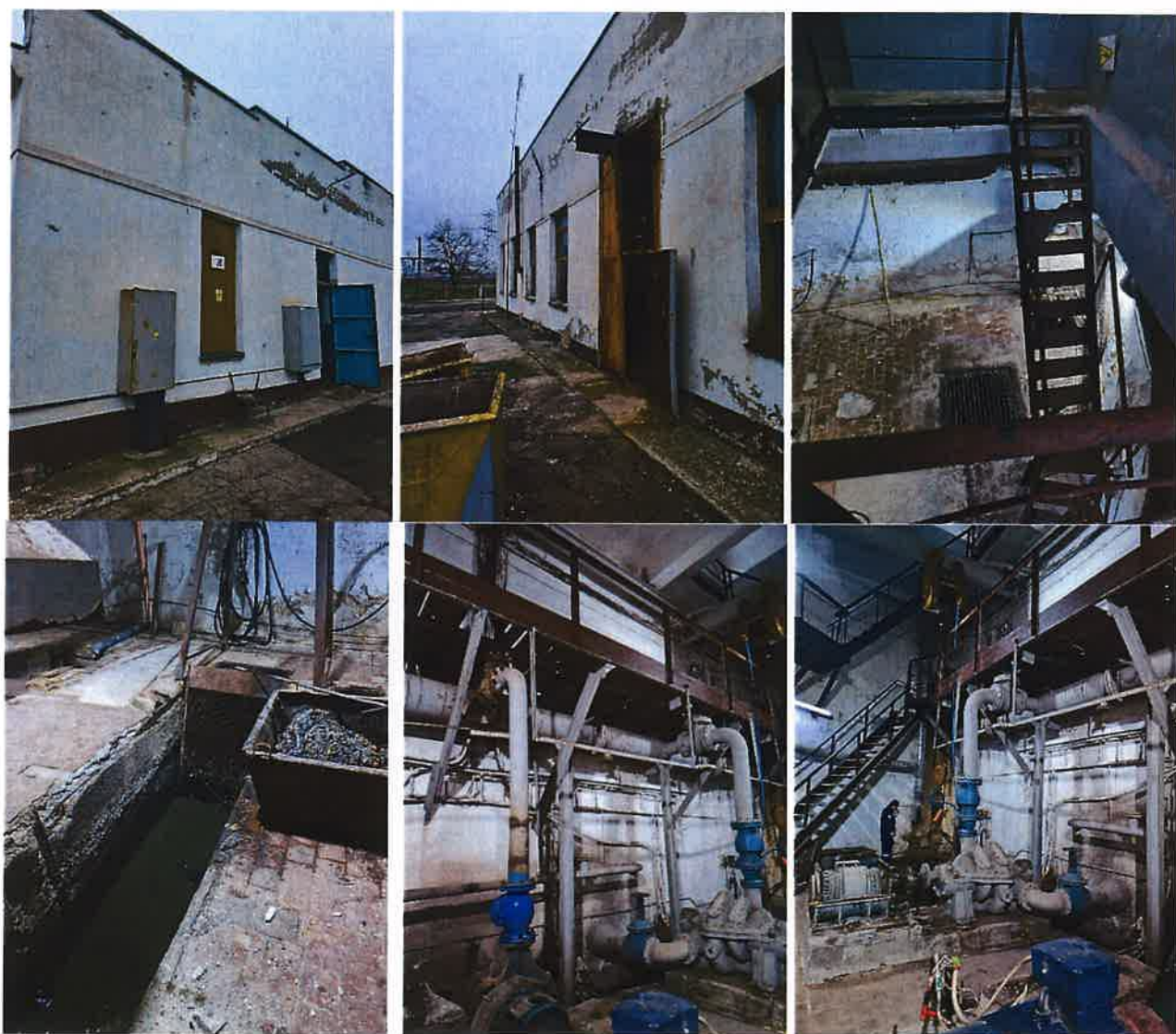
Figura 3-6. Starea stației de pompare existente (SPAU1)
